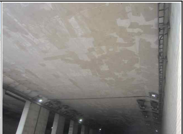
상부슬래브 하면 전경
